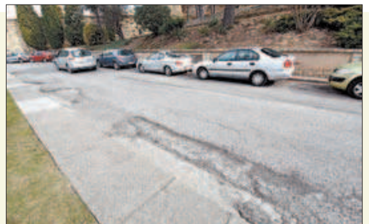
FOTO: N. García / La calzada de la subida al Turó presenta baches
