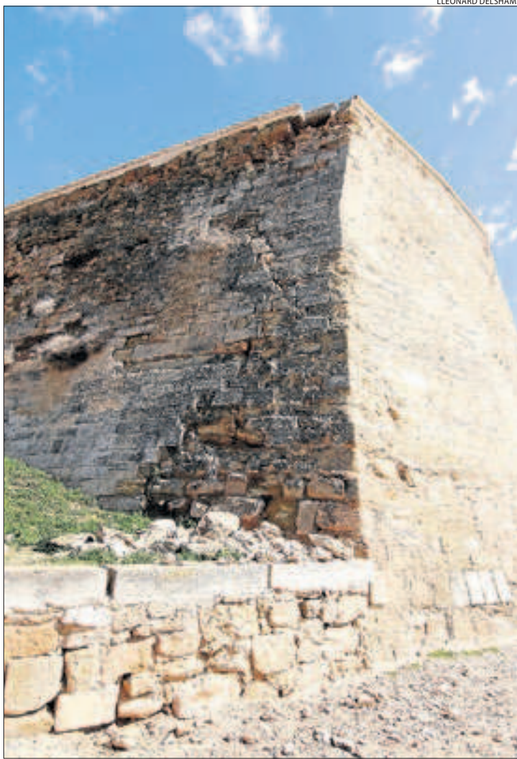
El tram de muralla de la Seu d'on han caigut grans pedres.
